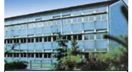
1968 yılında Herbert Fitzek'in beton kalıp elemanları ile yapılmıştır: Speyer-Berghausen'deki ortaokul.
