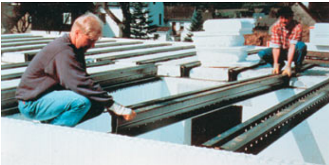
Isorast tavan kirişlerinin hafifçe aktarılması
