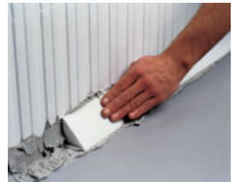
Kertik ile yapıştırma
